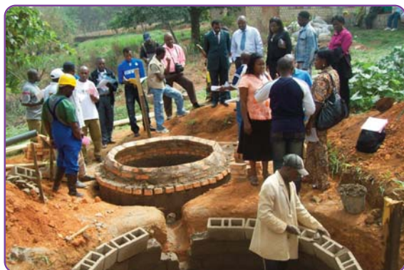
Construction d'un système Biogaz à Bafut - Bamenda
